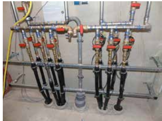
Abbildung 2: Geothermiesondenverteiler
