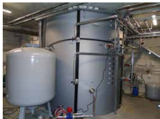
Abbildung 4: Großpufferspeicher (31 m 3 )
